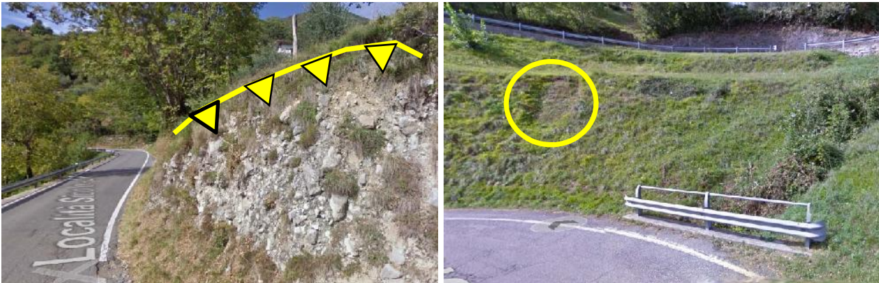
Forme di “Frane quiescenti puntuali” indicate nell’attuale carta del P.A.I. (Geo.Te.C., 2010,) ma nel presente lavoro ritenute non conformi alle definizioni dei dissesti del P.A.I. e quindi eliminate dalle mappe
