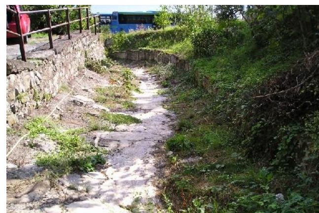
L' alveo della valle delle Pertiche a monte e a fianco dei condomini di Casella: poco prima dell'immissione nel lago l'alveo è contenuto tra muri spondali con selciato di fondo.
