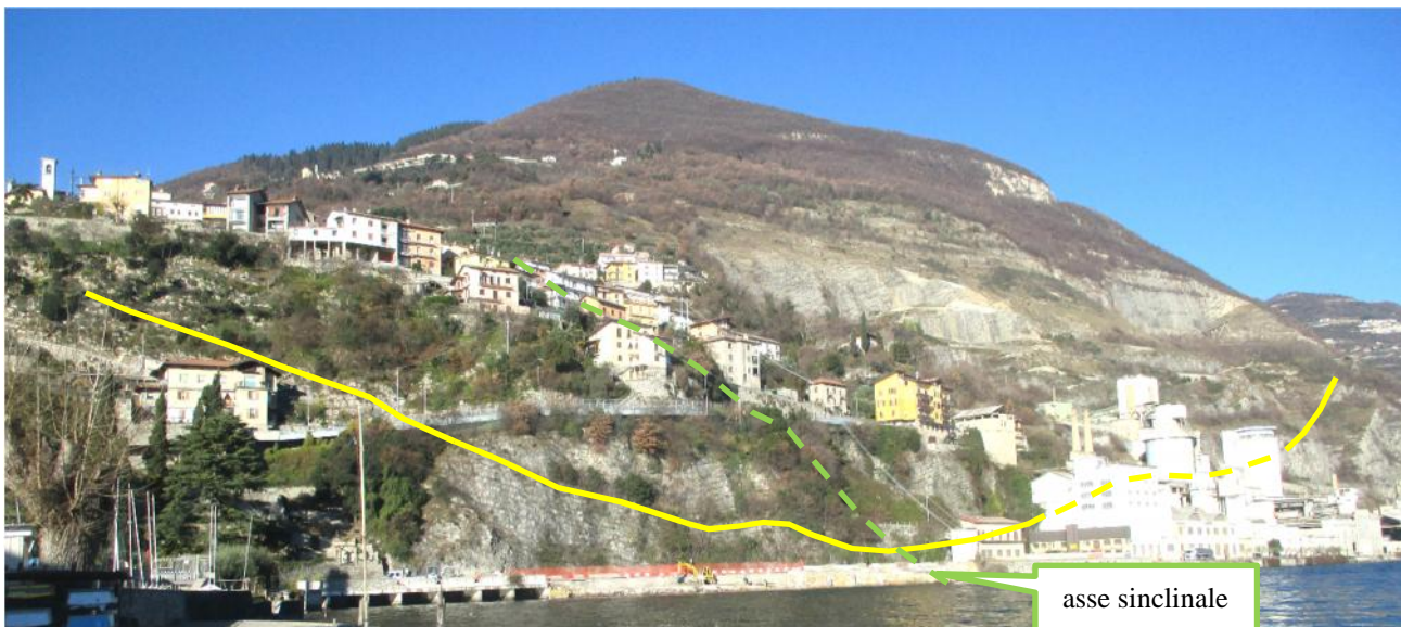
sinclinale di Tavernola Bergamasca con asse presso i lavori di allargamento della strada litoranea
