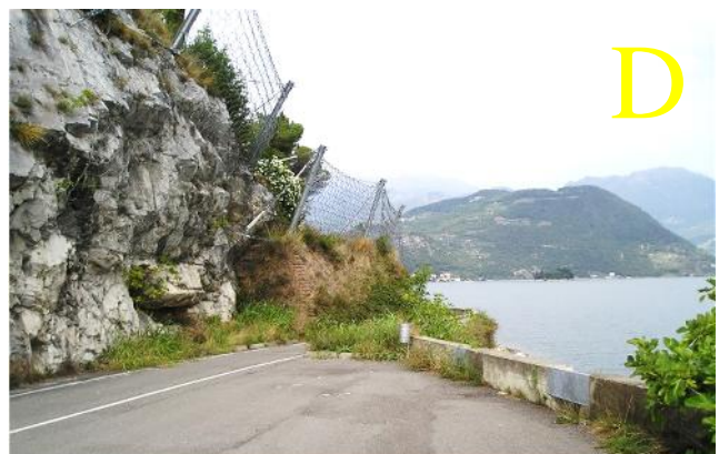
A-B: la strada litoranea del Corno di Predore prima (2006) e dopo (2011) la costruzione delle gallerie paramassi; C: protezioni divelte presso una delle gallerie artificiali; D: barriere elastoplastiche e tomo in terra armata
