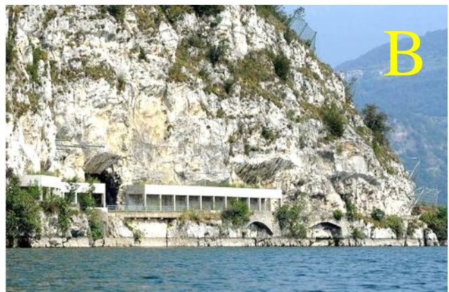
A-B: la strada litoranea del Corno di Predore prima (2006) e dopo (2011) la costruzione delle gallerie paramassi; C: protezioni divelte presso una delle gallerie artificiali; D: barriere elastoplastiche e tomo in terra armata
