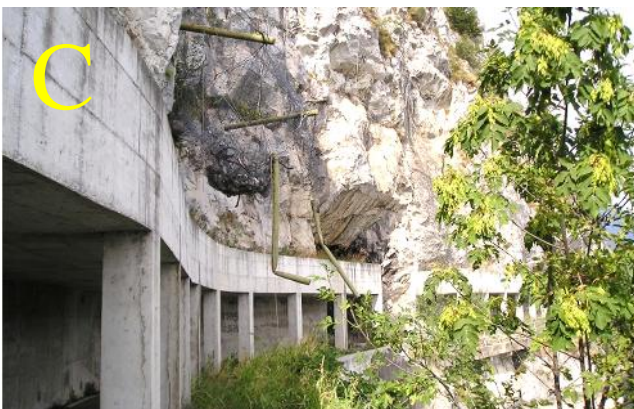
A-B: la strada litoranea del Corno di Predore prima (2006) e dopo (2011) la costruzione delle gallerie paramassi; C: protezioni divelte presso una delle gallerie artificiali; D: barriere elastoplastiche e tomo in terra armata
