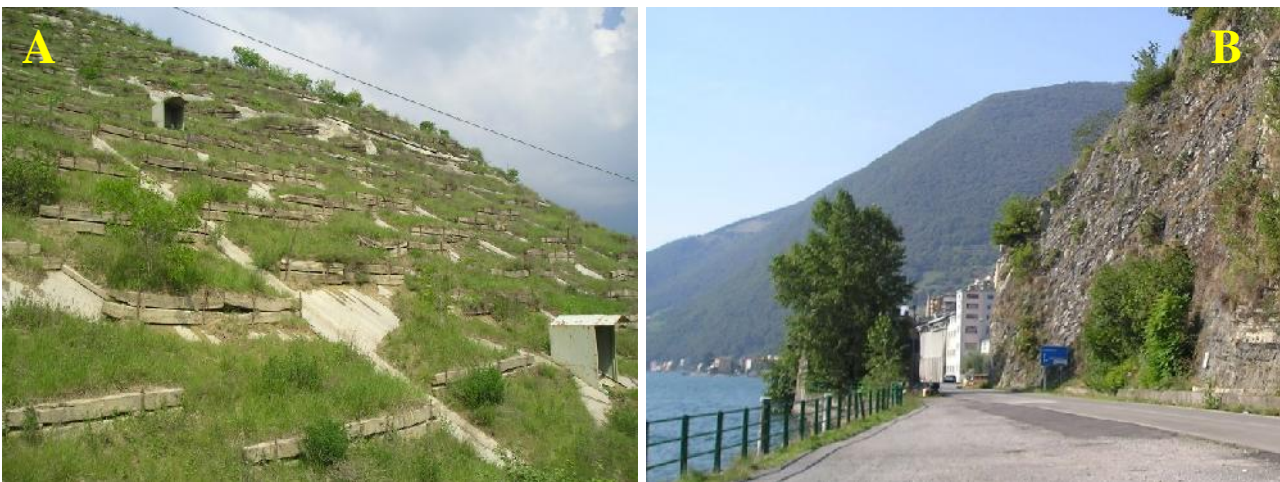
Frane stabilizzate (Fs): A) scivolamento lungo strato a Scapioni con estensimetri di controllo e terrazzette di rinverdimento; B) reti addossate sulla parete rocciosa presso l’innesto della nuova strada per Parzanica.
