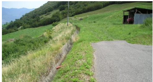
Briglie in legname e pietrame e in muratura sul Mondara e il canale di gronda (fosso di guardia) presso Cortinica
