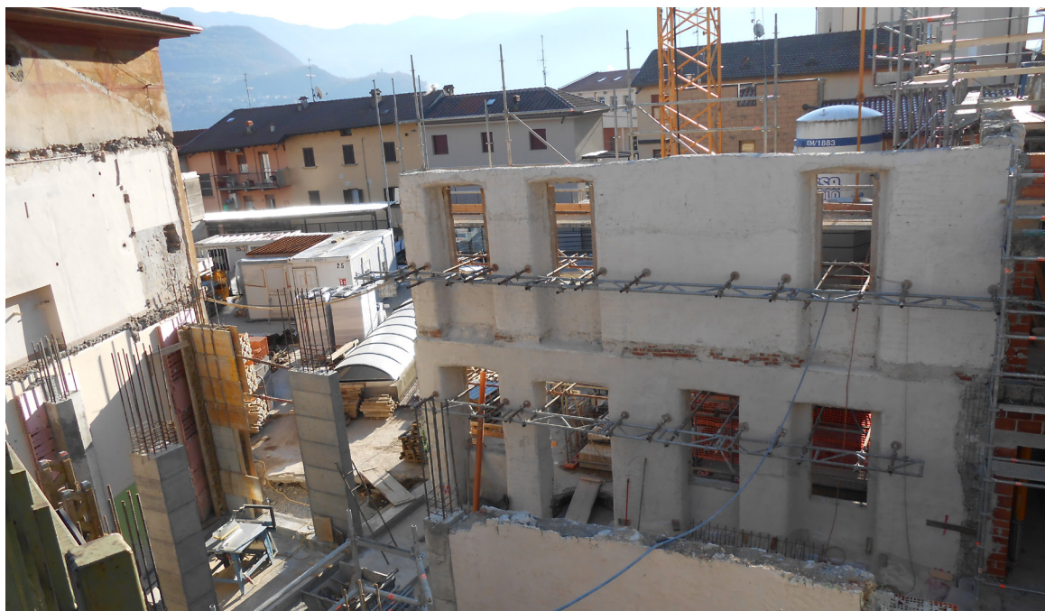
Nella Foto Lavori in corso dell'edificio scolastico
