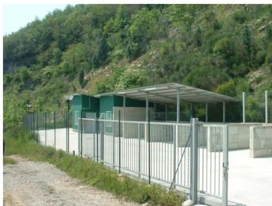
L'area destinata alla piazzola ecologica è di circa 1970 mq e all'interno è stata realizzata la stazione ecologica, struttura necessaria al corretto smaltimento dei rifiuti cittadini. Essa è costituita da una struttura in cemento armato che sorregge una tettoia metallica che copre la piattaforma da cui si accede ai container della raccolta differenziata.
