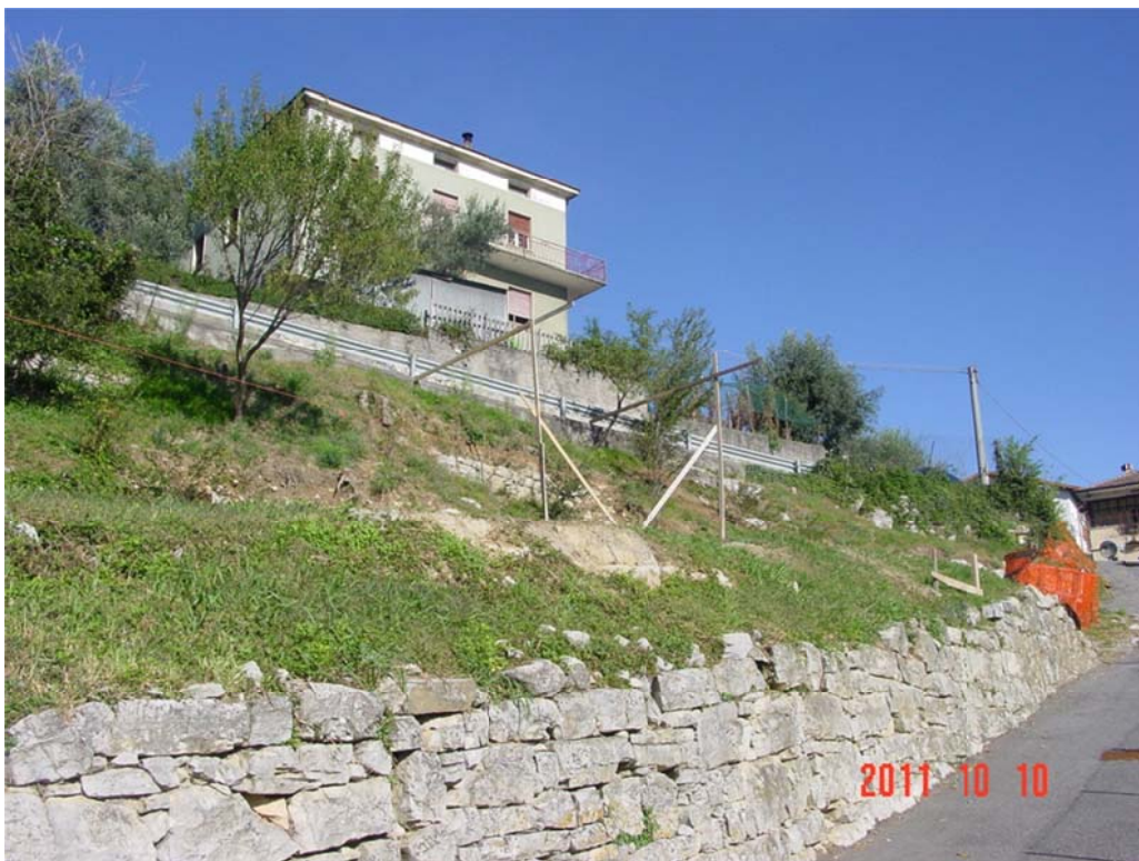
Vista da via Rino, su parcheggio esistente
